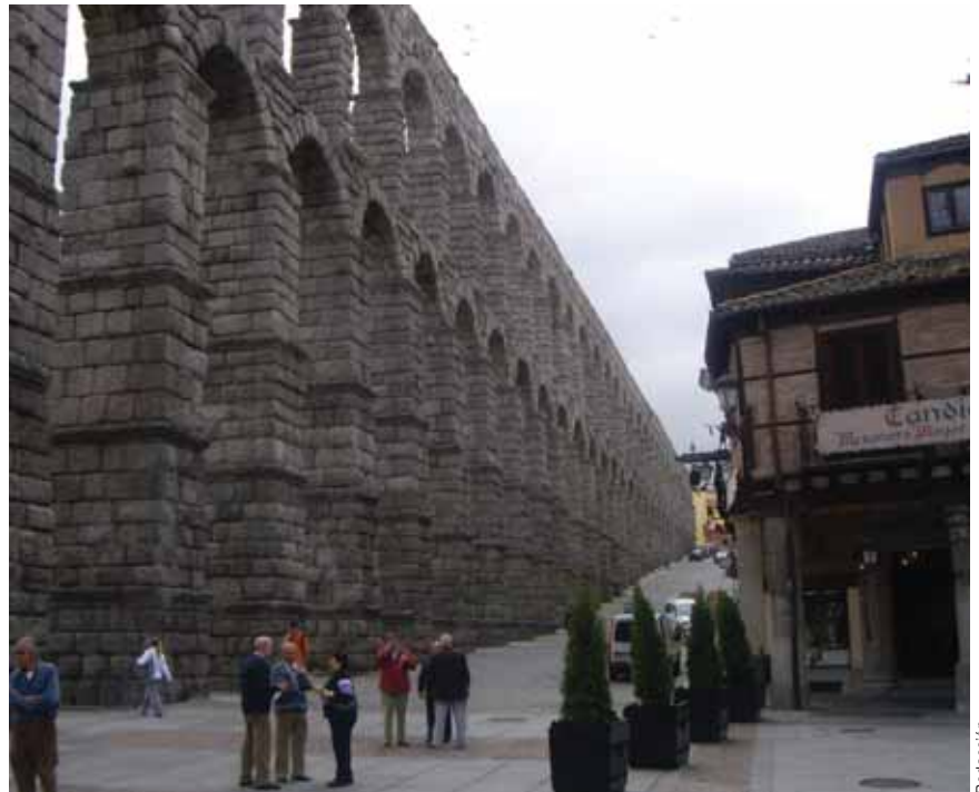
La avenida de Fernández Ladreda, en Segovia, es una amplia vía peatonal situada justo al lado del monumental acueducto que cruza el centro de la ciudad.
