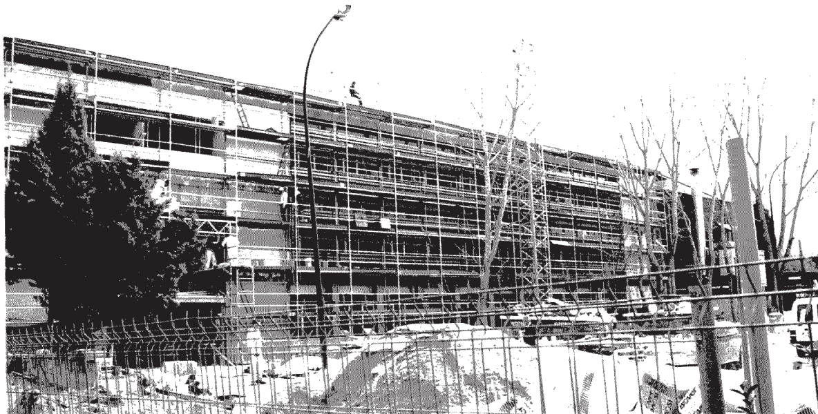
Aspecto exterior del nuevo edificio en construcción, destinado a biblioteca
