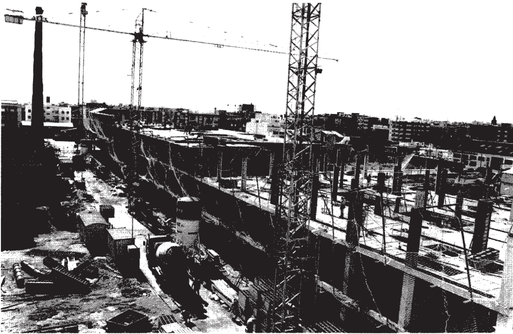
Estado actual que ofrecían las obras de la futura Universidad Cardenal Herrera CEU a mediados de febrero pasado
