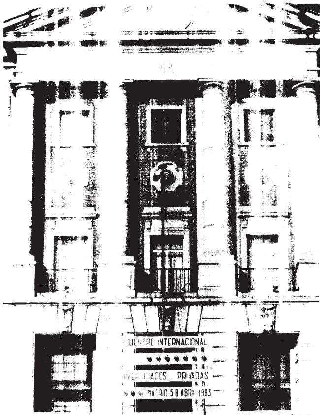
Vista parcial de la fachada del Colegio Mayor San Pablo, donde se celebró el Encuentro.
